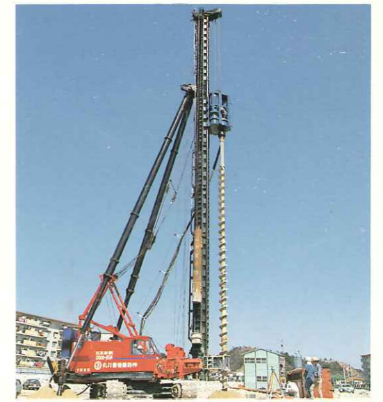
名谷団地特殊基礎工事
