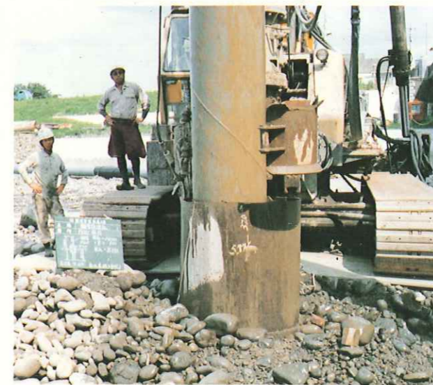
福岡県山国川歩道設置工事
