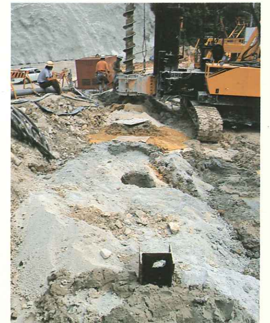
岡山県三石市金剛川災害復旧工事
