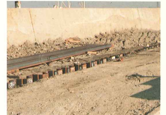
大阪府岸和田市阪南港堤防補強工事
