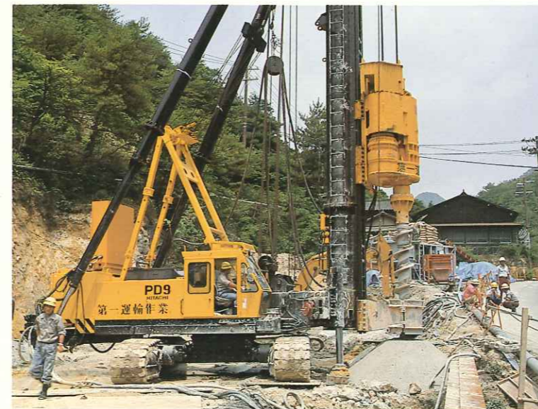
岡山県三石市金剛川災害復旧工事
