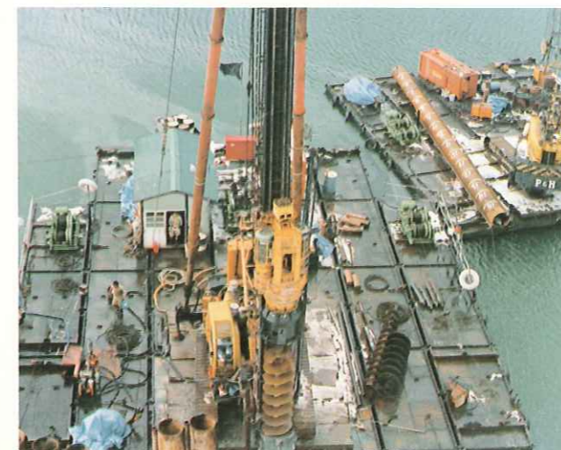
兵庫県引原地区擁壁根固工事
